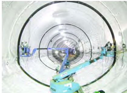
写真-2 防水シート設置状況
