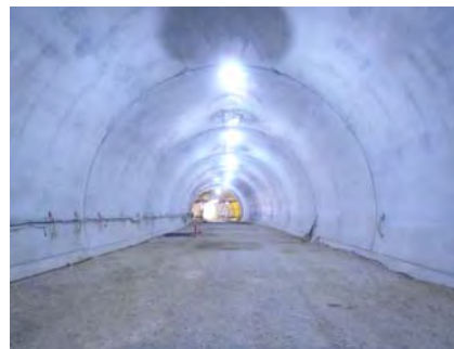
写真-3 覆工完了全景
