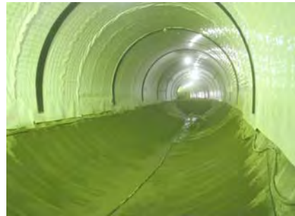
写真-1 インバート仕上げ吹付
