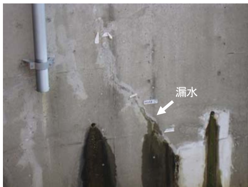
写真-1 ひび割れ修復後の再劣化の例
