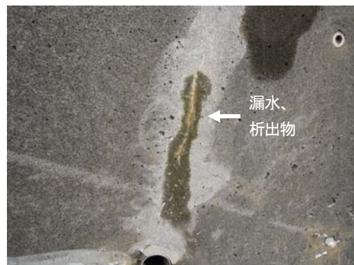
写真-1 ひび割れ修復後の再劣化の例
