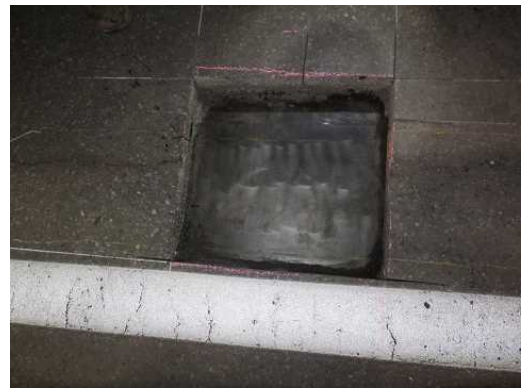
写真-6 調査箇所A 鋼床版上面状況
