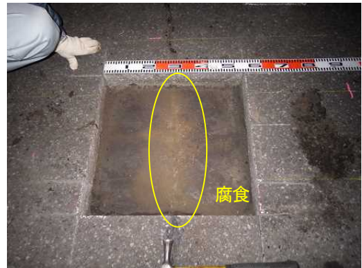
写真-7 調査箇所B 鋼床版上面状況
