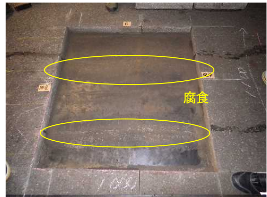
写真-8 調査箇所C 鋼床版上面状況
