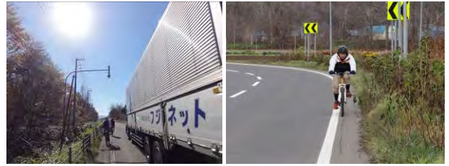
写真-3 自転車追越時の状況 写真-4 雑草繁茂による自転車走行空間の制限
