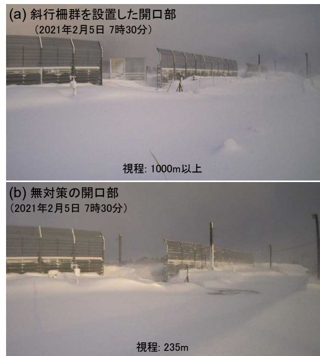
写真-1 地吹雪時の開口部の状況の例
