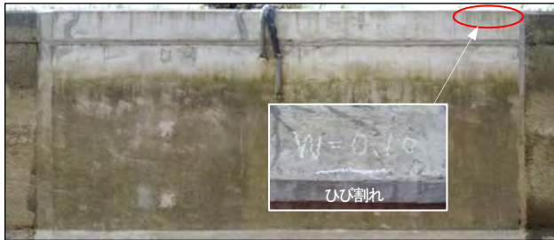
写真-3 A工法の用水路側壁面
