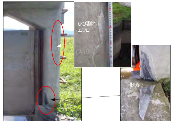
写真-7 B工法の門柱の状態
