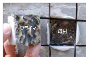
写真-13 B工法用水路部
