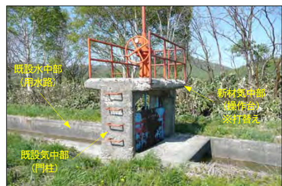
写真-1 試験施工の母材条件
