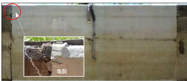
写真-5 C工法の用水路側壁面
