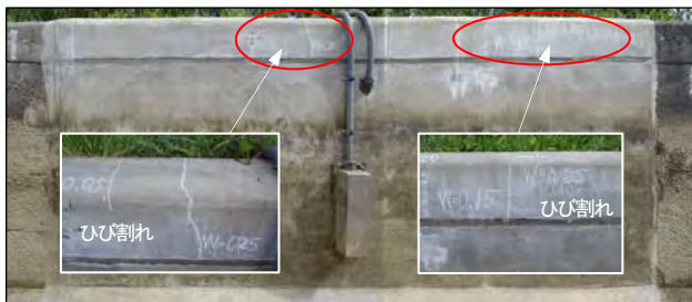
写真-4 B工法の用水路側壁面
