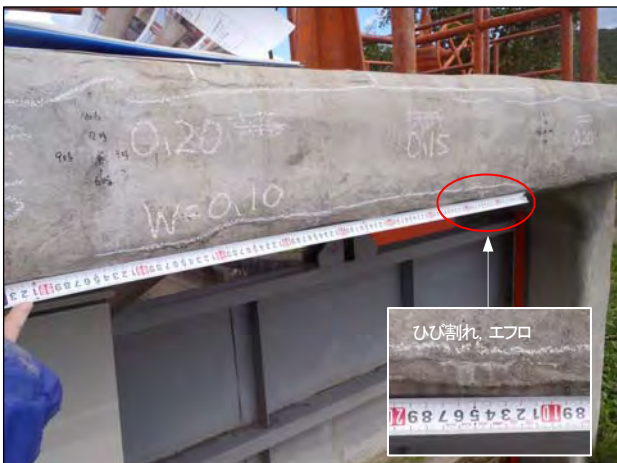
写真-10 B工法の張出スラブ側面の状態
