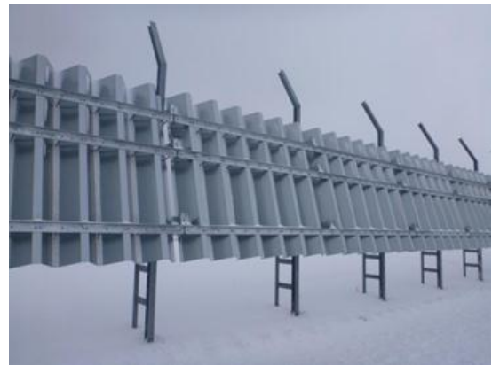
写真-2 考案した路側設置型防雪柵
