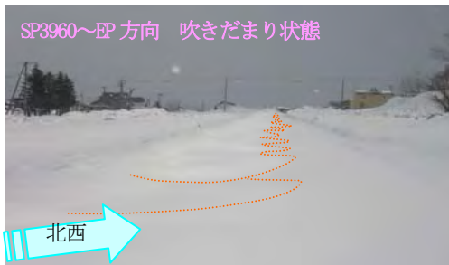
写真-1 防雪柵未設置区間の吹きだまり状況
