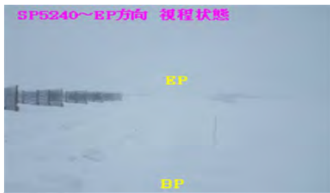
写真-3 防雪柵設置区間視程状況
