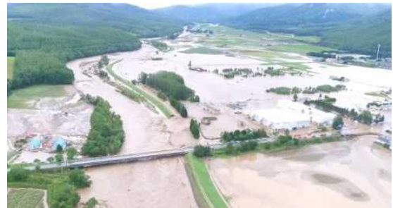
写真-1 堤防決壊 (南富良野町：北海道開発局提供)
