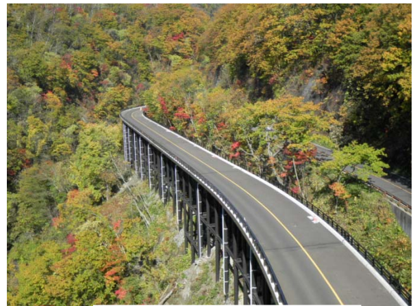
立体プレハブ栈橋全景
