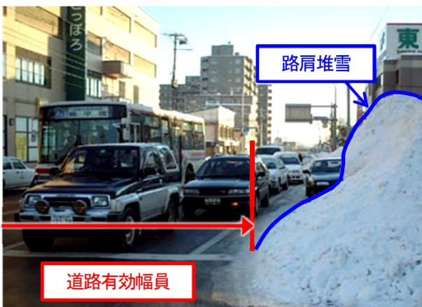
図-1 道路有効幅員の減少状況
