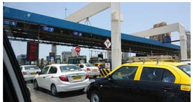
図-5 自動車専用道路の料金所
