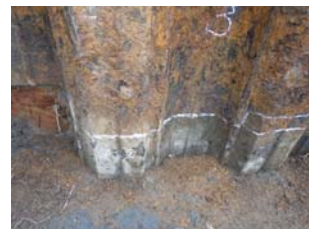
写真-5 健全部の状況 （第1号落差工気中部）
