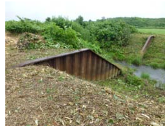
写真-1 第1号落差工 (平成27年8月19日撮影)
