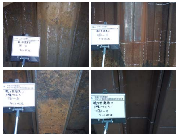
写真-2 ケレン後の状況
