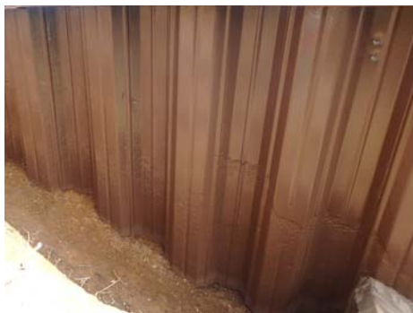
写真-6 補修後の外観(第1号落差工) (平成27年9月1日撮影)
