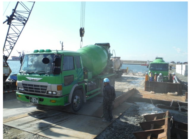
写真-1 アジテータ車の台船への乗船状況
