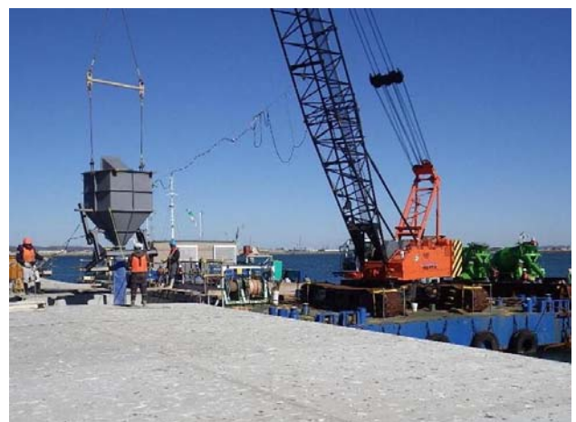
写真-3 コンクリート打設状況
