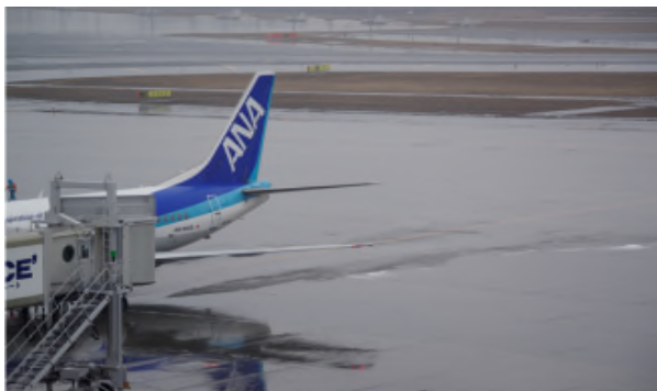
写真-4 国内線ローディングエプロンの水たまり状況
