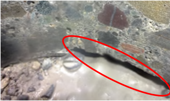
写真-7 コア採取後の空隙状況 (駐機15番スポット)
