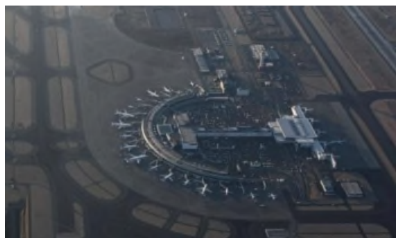
写真-1 新千歳空港国内線ローディングエプロン全景
