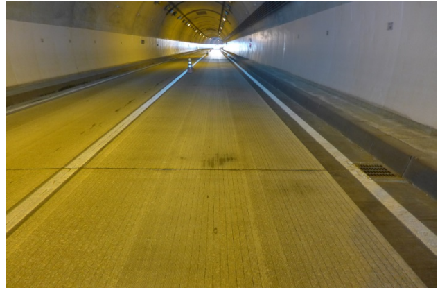
写真-4 DG工法施工後の路面
