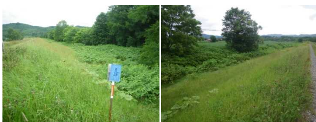
図 2-2 オオイタドリ対策工による生育抑制事例 (H25 施工 湧別川 野上左岸築堤)
