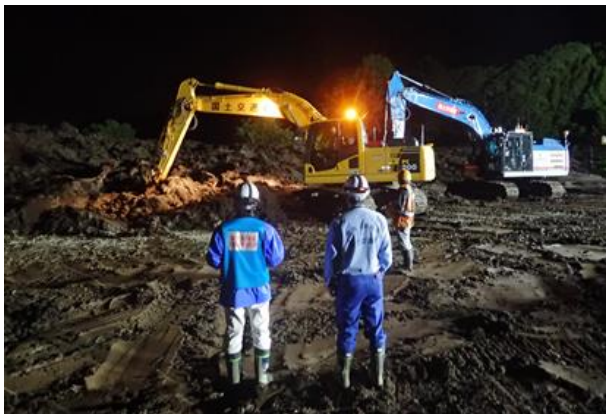
写真-5 夜間の作業状況（厚真町幌内地区）
