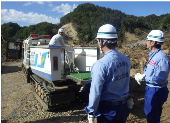
写真-8 水陸両用車による状況確認（厚真川上流）
