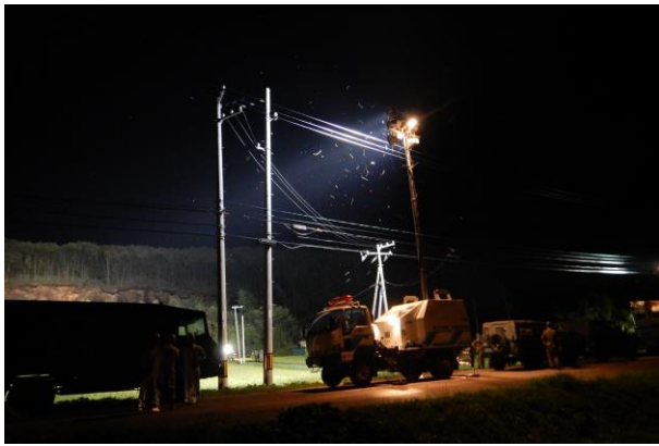
写真-3 夜間救出作業支援（厚真町吉野地区）
