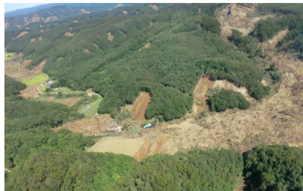
写真-1 土砂崩落の空撮 (厚真町)
