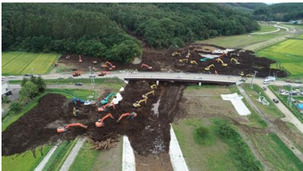
写真-4 昼間の作業状況全景（厚真町幌内地区）
