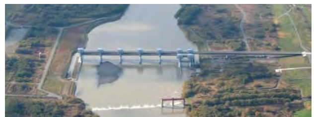
写真-1 新石狩川頭首工状況（H25.10.29現在）
