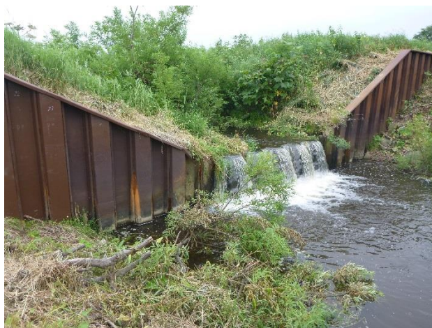
写真-1 鋼矢板落差工
