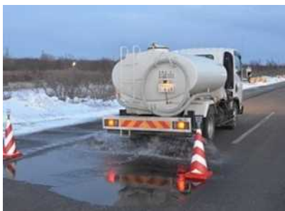
写真4 氷膜路面作製状況
