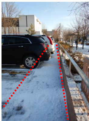
写真-4 T庁舎車止め
