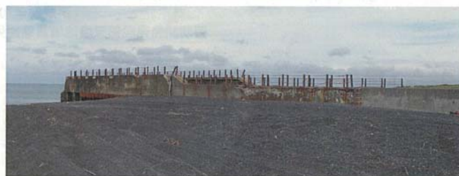
写真-1 開渠工全景
