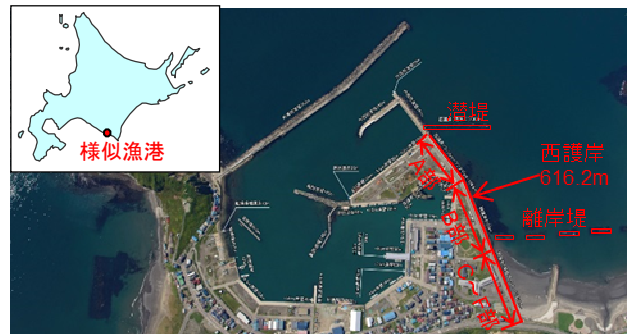
写真-1 様似漁港全景 (平成30年9月撮影)
