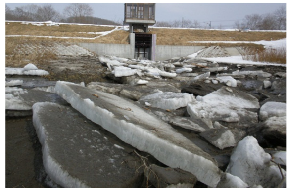
写真-2 樋門吐口水路の氷板痕跡 (2011年3月14日撮影)
