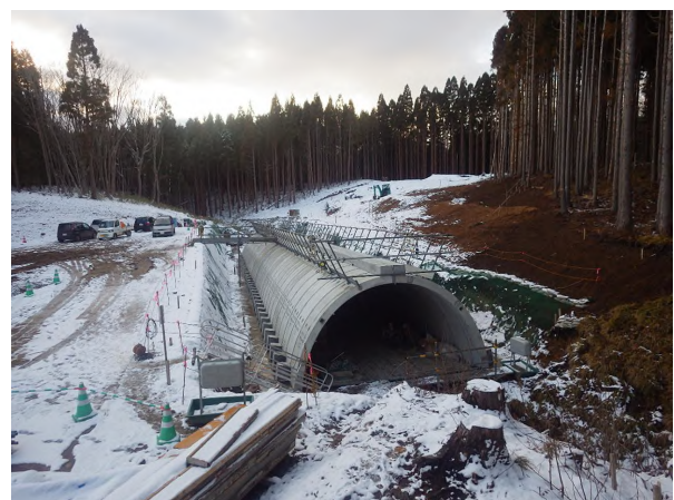
図-8 アーチカルバート本体の完成
