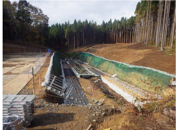
図-6 アーチカルバート基礎部の施工
