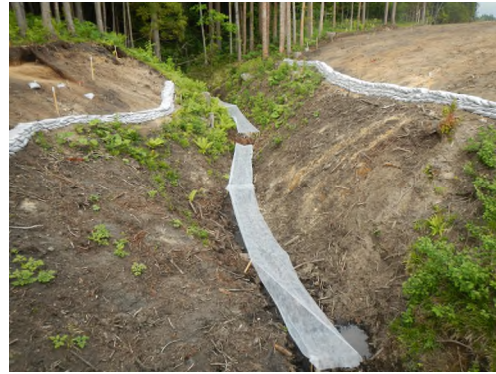
図-10 応急的措置としての寒冷紗の設置
