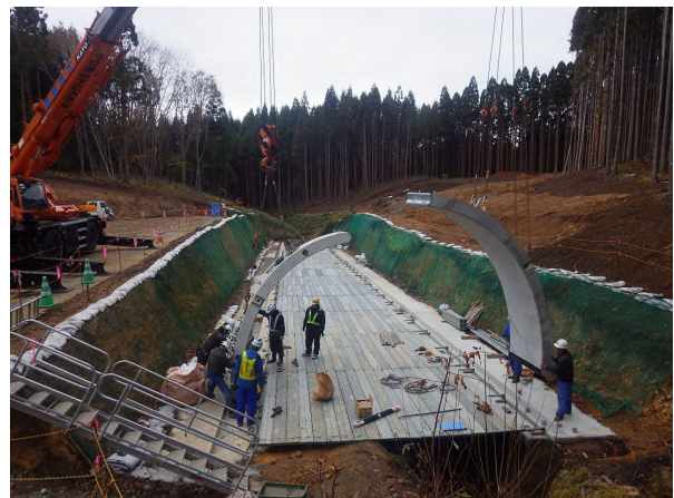
図-7 アーチカルバート本体の施工
