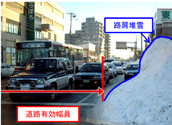
写真1 道路有効幅員の減少状況
