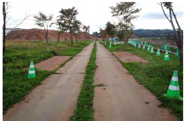
図-7 敷鉄板の布設状況
