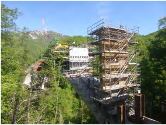
写真-11 鉛直材施工状況
