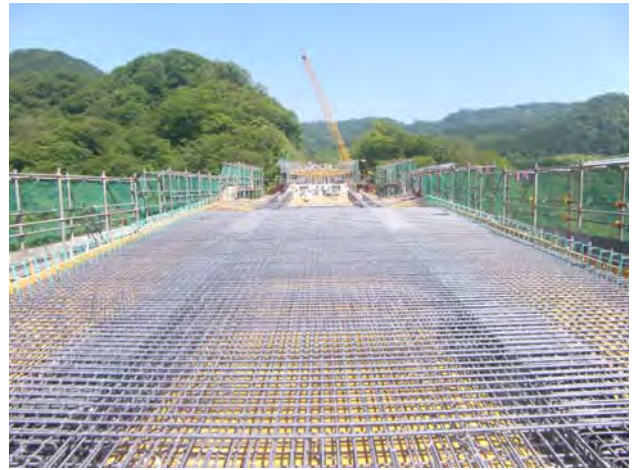
写真-12 補剛桁施工状況
