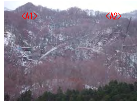
写真-5 A1側4次ロアリング状況
