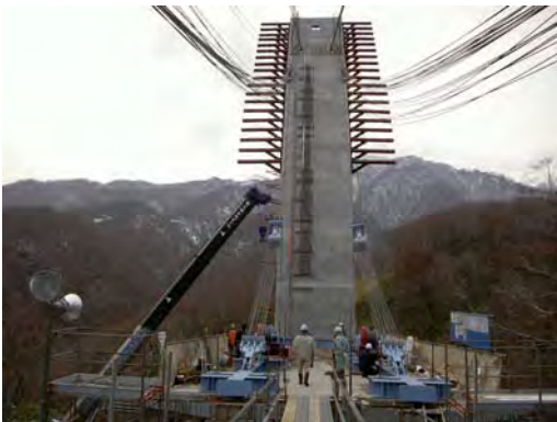
写真-2 ウインチ設置状況
