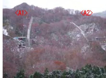
写真-4 A2側3次ロアリング状況
