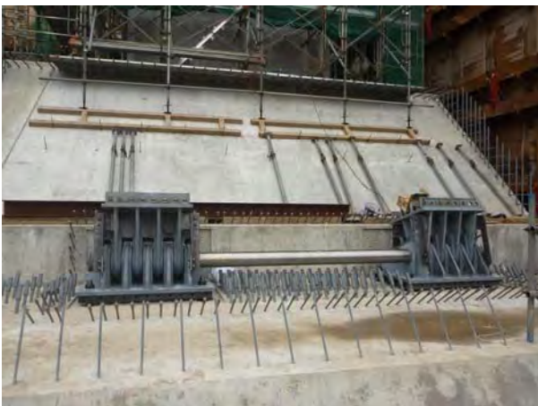
写真-8 連結ピン設置状況
