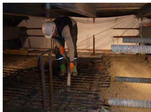
写真-10 閉合部コンクリート打設状況
