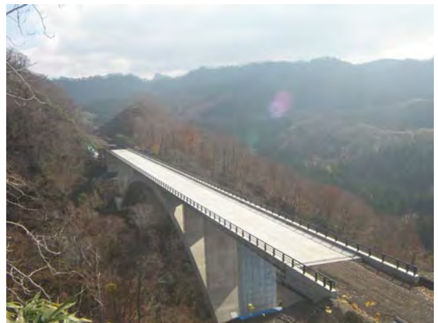
写真-13 橋面工施工完了状況
