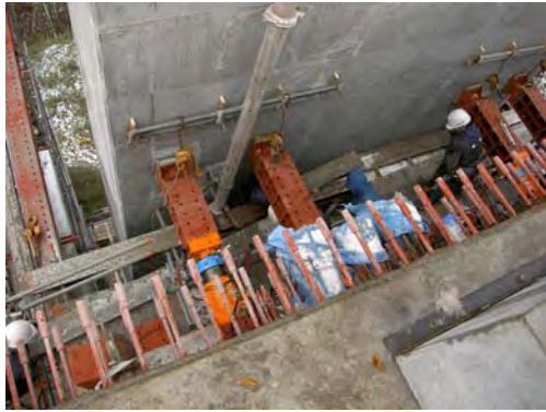
写真-1 押しジャッキ設置状況
