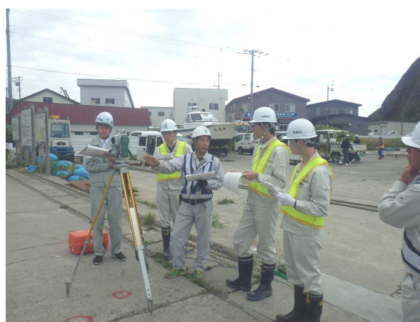
写真-1 受発注者インターンの合同測量実習の状況
