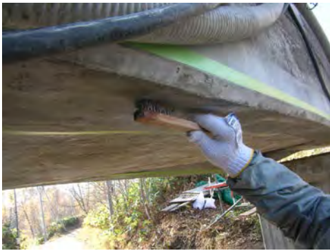
写真2 下地処理作業
