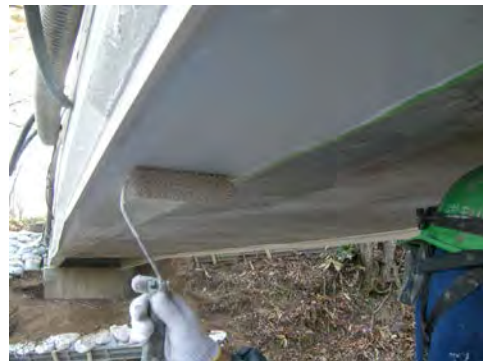
写真6 上塗り塗装作業
