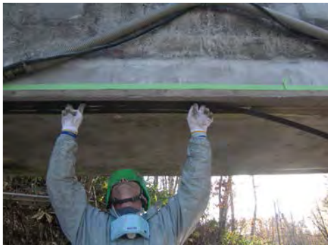
写真3 CFRPプレート貼り付け作業
