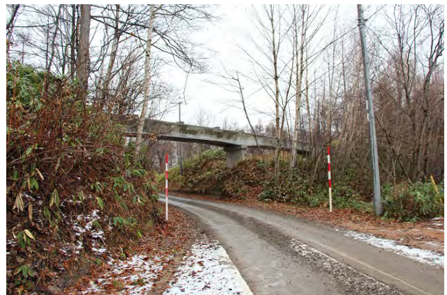
写真-1 コンクリート水路橋
