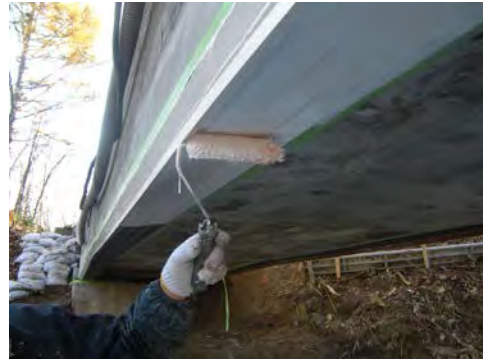
写真5 中塗り塗装作業
