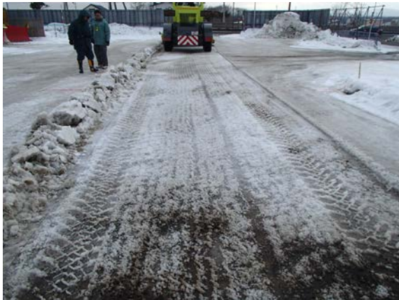
写真-5 除雪作業計測状況（路面整正装置不稼働）
