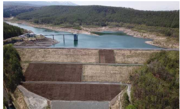
写真-10 復旧後堤体全景
