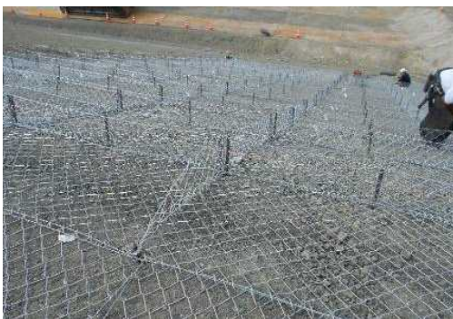
写真-7 かごマット設置
