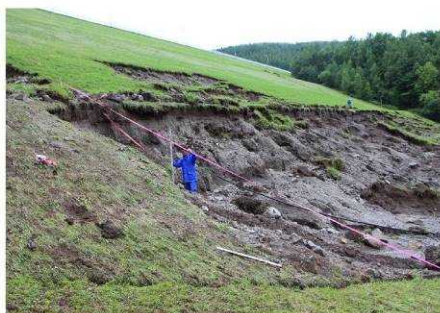
写真-2 法面下段の状況
