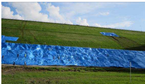
写真-4 ブルーシートの設置状況
