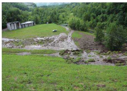
写真-3 堤体下流の流出土砂
