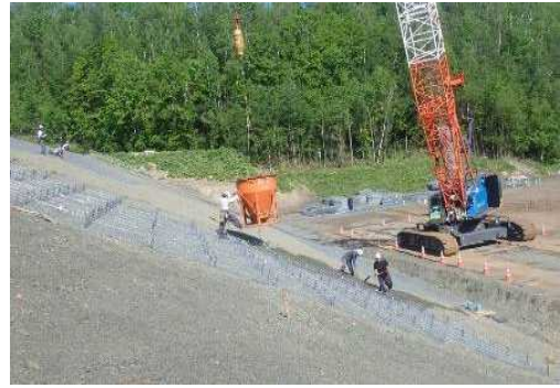
写真-8 碎石投入
