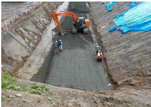
写真-5 堤体盛立
