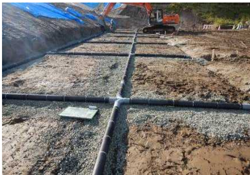
写真-6 排水管敷設
