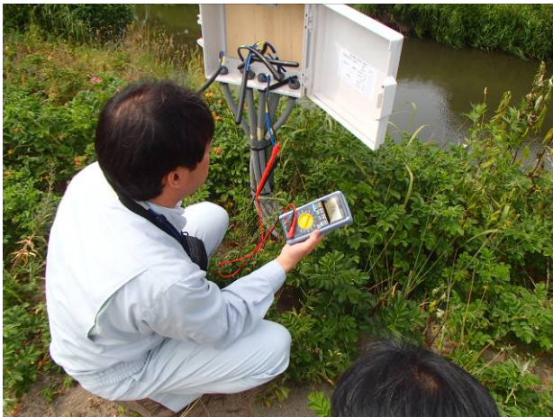
写真- 2 自然電位測定状況
