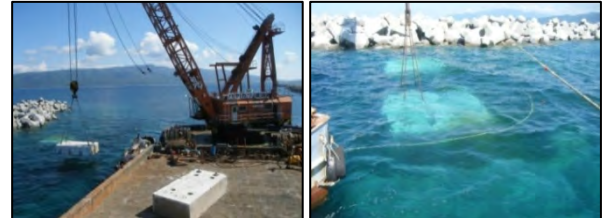
写真-3 嵩上げ試験施工状況
