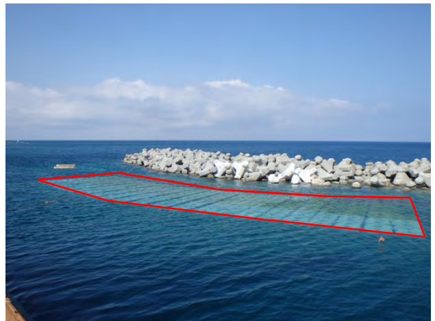
写真-6 嵩上げ改良（赤枠部）
