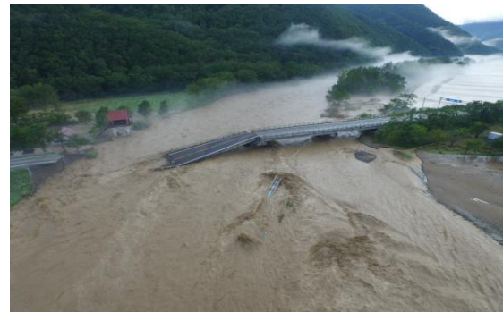
(図-7) 千呂露橋落橋状況
