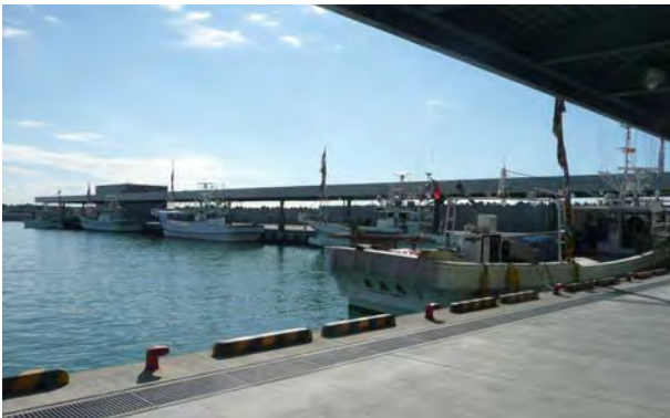
写真-3 供用式当日の新港地区の様子
