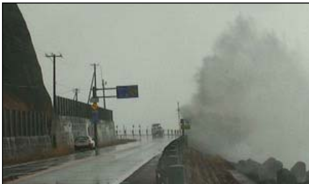
写真-1 海岸道路の越波状況
