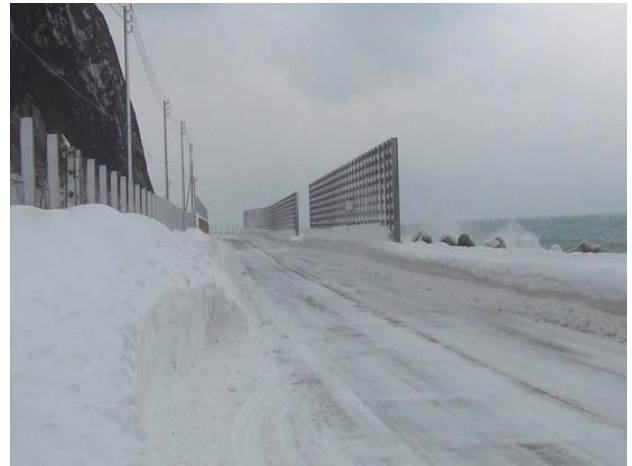
写真-3 25年度に設置した防波フェンス
