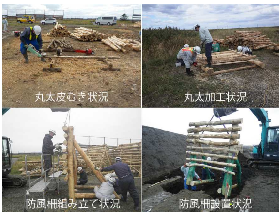
写真-2 防風柵製作と設置状況
