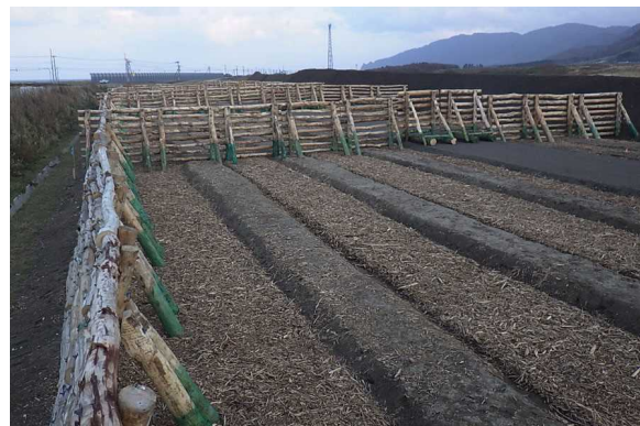
写真-5 チップマルチング敷き均し後の状況
