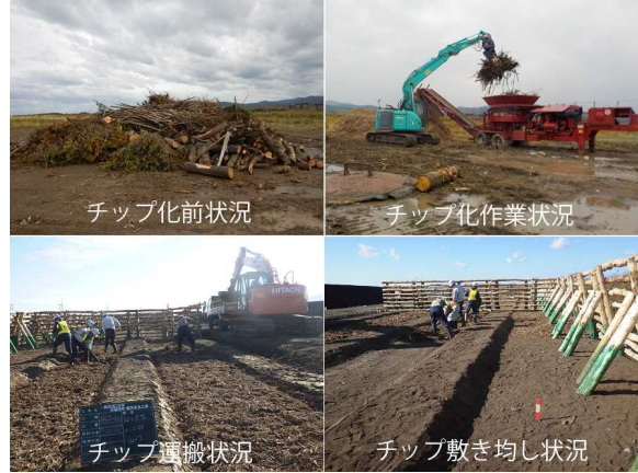
写真-4 チップ化および敷き均し作業状況
