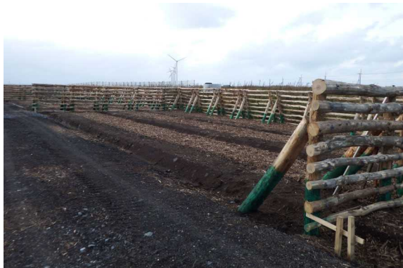
写真-3 防風柵設置後の状況
