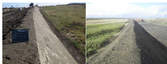
写真-1 防雪盛土施工状況と施工後
