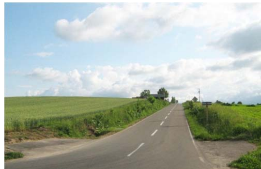
写真-2 美瑛町での地中化事例 (道路左側・実施後)
