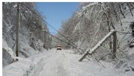
写真-3 暴風雪に伴う電柱の倒壊・電線の切断 (豊浦町ホームページ 3) より引用)
