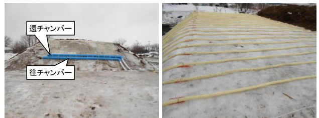
図-5 採熱管布設（法面）法面（左）、天端（右）
