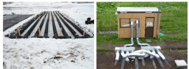
図-4 採熱管布設（左）、計測室（右）
