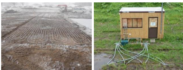
図-2 採熱管布設（左）、計測室（右）
