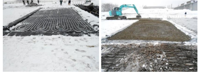
図-3 採熱管布設（左）、埋戻（右）
