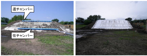
図-6 探熱管布設 (左)、シート布設 (右)
