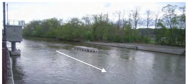
写真-2 完成後 大曲堰全景（順流時）
