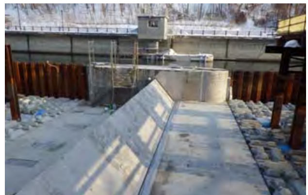
写真-1 完成後 左岸ゲート
