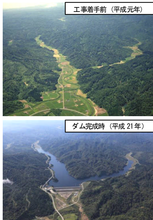
図-1 留萌ダムの工事着手前とダム完成時の状況
