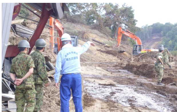
写真-6 道路啓開状況(厚真町 町道幌内線)
