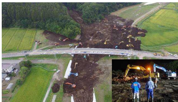
写真-7 河道閉塞土砂撤去状況(厚真町 厚真川)
