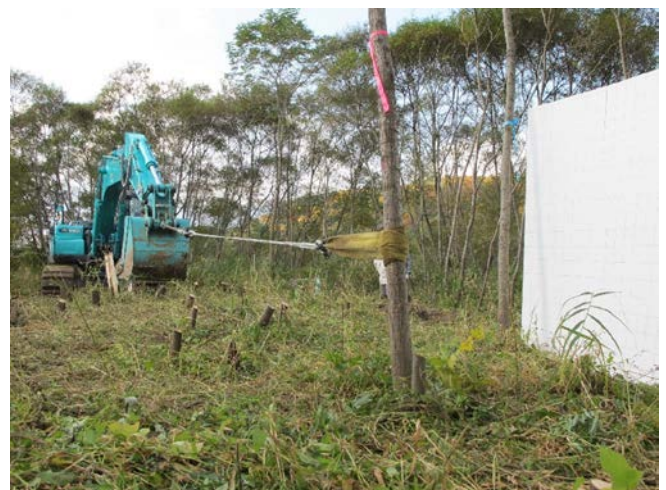
写真-2 引き倒し試験の状況
