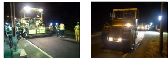
写真-1 施工状況
