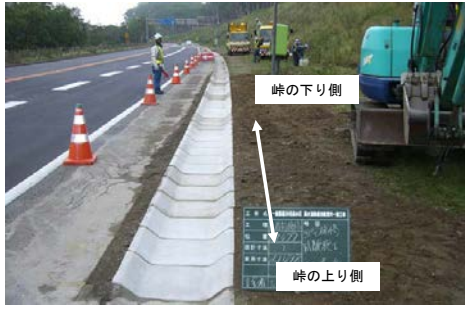
写真-1 6合目付近の試験施工状況
