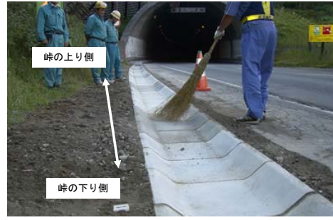
写真-2 9合目付近の試験施工状況
