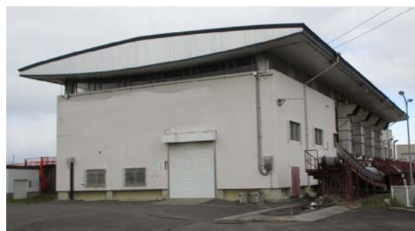
写真-1 昭和40年建築の排水機場
