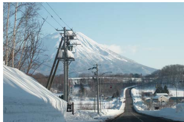
写真5 地域景観の魅力低下させている電線電柱類
