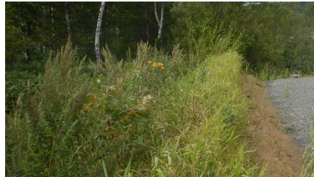
写真-1 泥炭張付法面に草本が繁茂している様子
