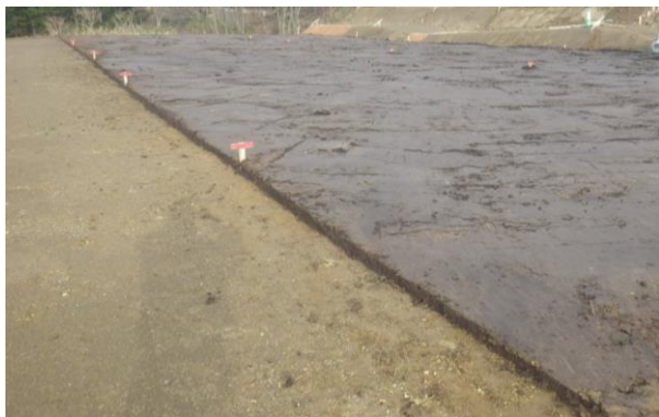
写真-2 泥炭の覆土状況(施工直後)
