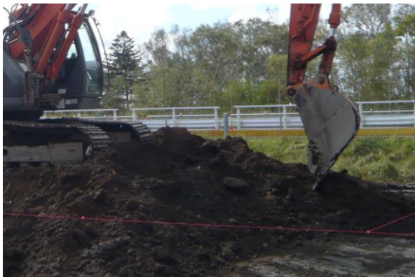
写真-5 破砕した固化土の様子
