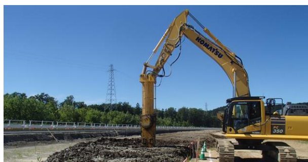
写真-3 中層混合処理工(攪拌翼併用スラリー方式)
